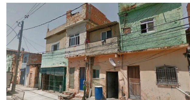
Na foto, a base do ICN e o canteiro da construtora em instalação na Rua Júlio do Carmo.
